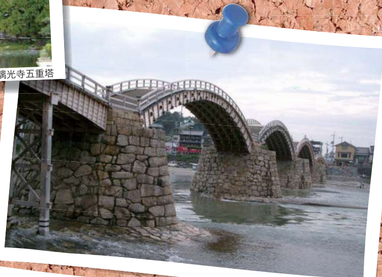
岩国市・錦帯橋
