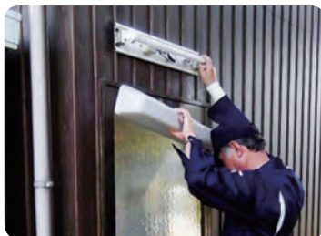
蛍光灯の蛍光管交換
