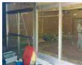
自分達での改修作業
